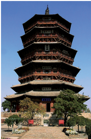
▲ Εικ. 4-6. Το κτίριο Yingxian Wooden Pagoda στην Κίνα. ( http://en.wikipedia.org/wiki/File:The_Fugong_Temple_Wooden_Pagoda.jpg )
